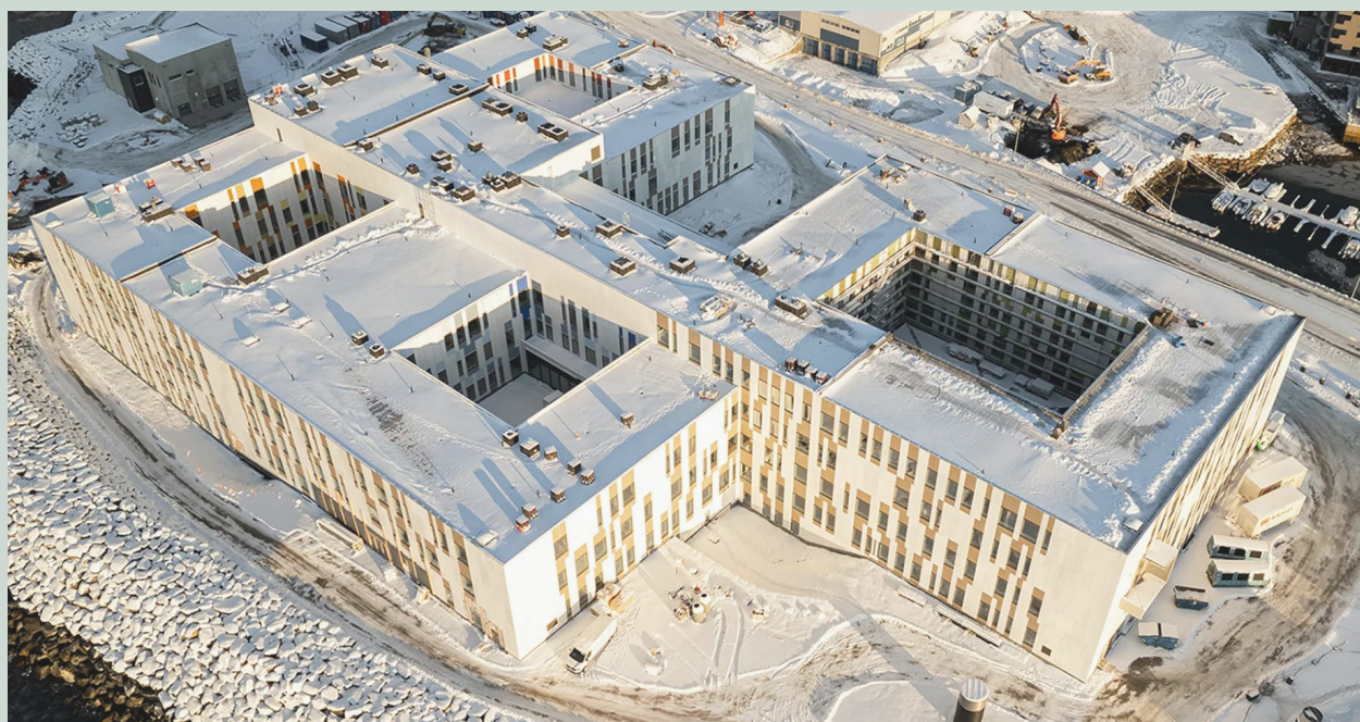
Nye Hammerfest sykehus.
