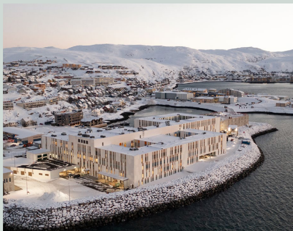
Nye Hammerfest sykehus.
